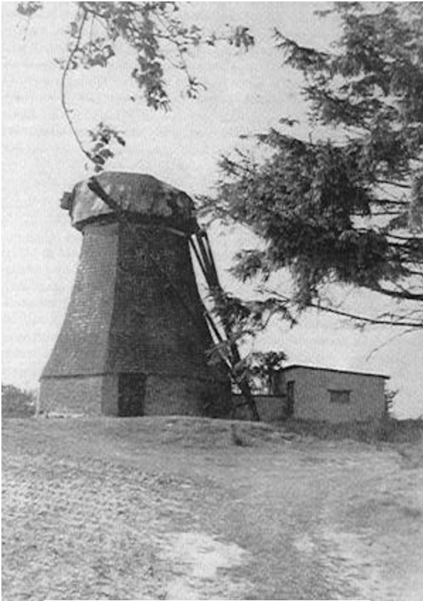
Die Hilter Mühle: vor ihrer Renovierung
