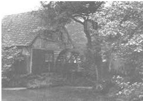
Vor der Renovierung
